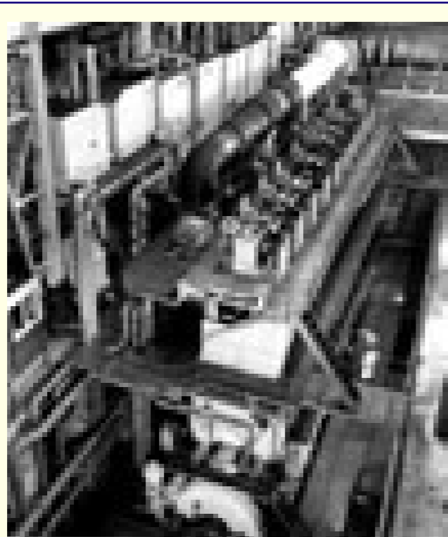
Η πρωτότυπη εννεακύλινδρη μηχανή DOXFORD τύπου «J» στη κλίνη δοκιμών PALLION το 1964.
