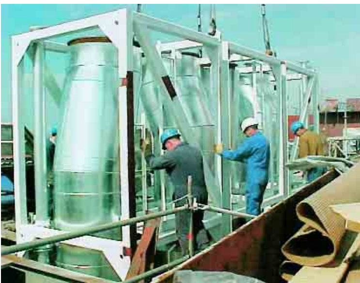
Από την εγκατάσταση του EcoSilencer στο «PRIDE OF KENT» της P&O. Στην ομιλία του κατά την INTERFERRY 2005 στην Αθήνα, ο κ. John Garner της P&O ανέφερε πολύ ευνοϊκά για την απόδοσή του. Το ίδιο και ο κ. Mel Davies του BMT περί αυτής της Αφαιρετικής Τεχνολογίας.
